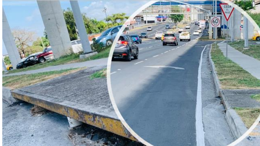
Ilustración 8. Altura de estructura de drenaje construido en 2016 sobre la Domingo Diaz.
