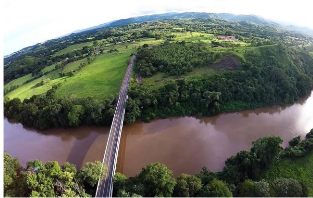
Figura 23. Puente sobre el Rio San Pablo, Soná. Fuente: Fotografía Rainier González.
