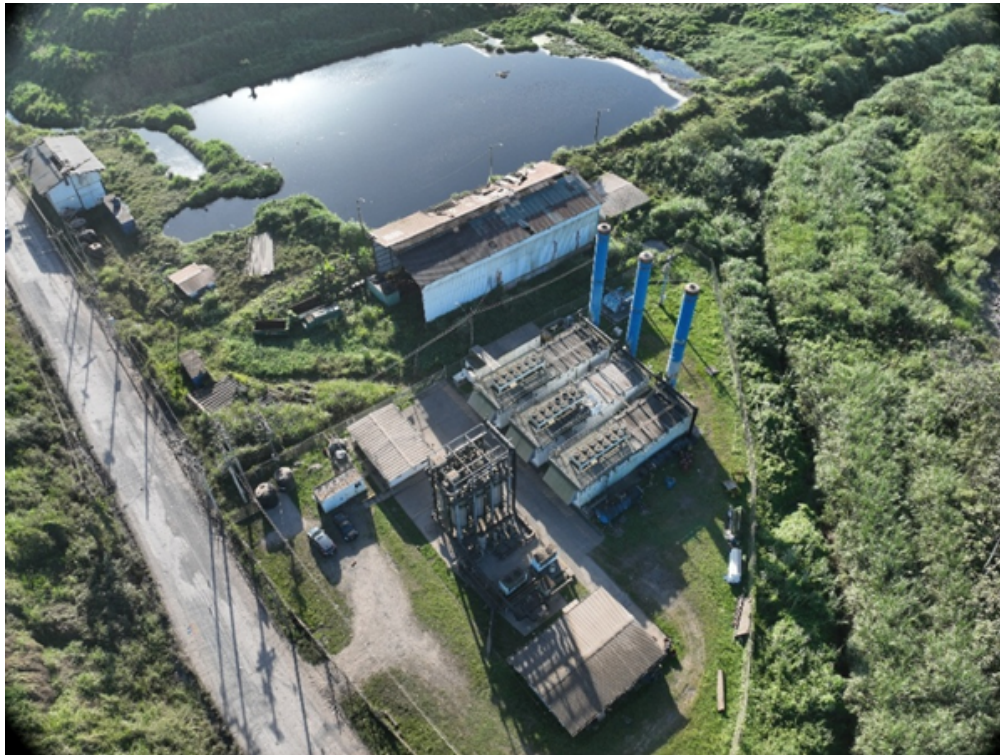
Figura 4: Vista aérea de piscina lixiviados y planta de generación de energía inoperativas. Fotografía proporcionada por la AAUD, tomada el 17 de enero de 2025. Reproducida con permiso.
