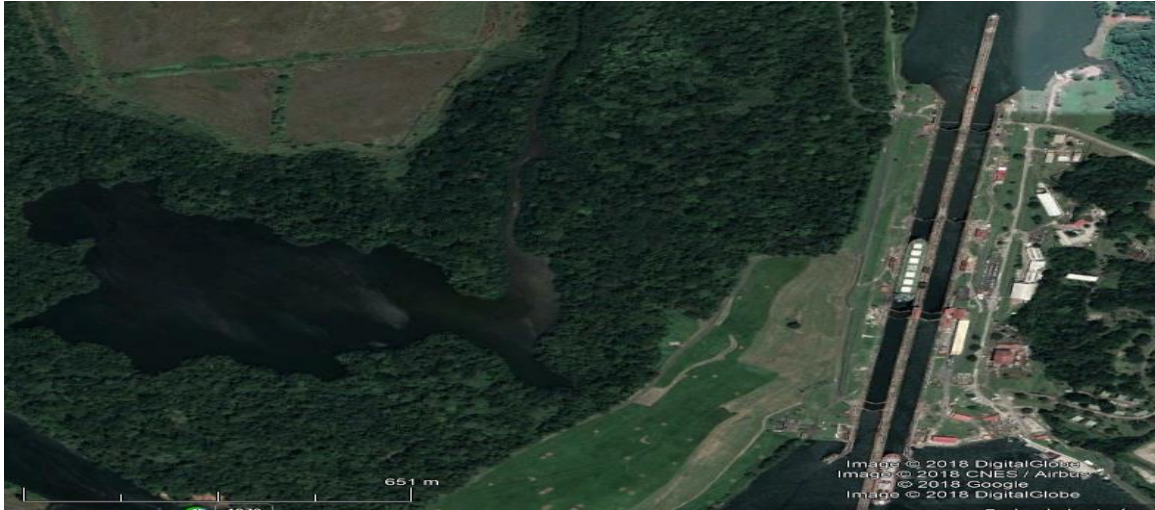
Figura 10: Esclusa de Gatún. Tres cámaras.
